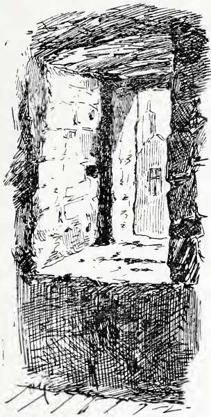
N° 6. — La fenêtre centrale du grenier (pignon postérieur).
